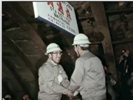
常磐自動車道日立トンネル貫通
