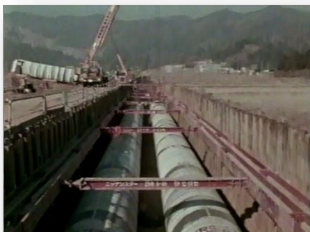
霞ヶ浦用水パイプ敷設(新治工区)
